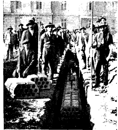
Sl. 18. POLAGANJE BETONSKIH BLOK-CIJEVI ZA KABLOVE U ZAGREBU
