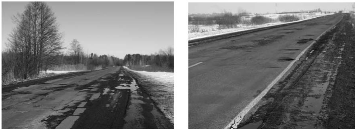
Рис. 2. Місця проникнення вологи через покриття
