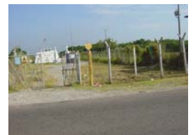
Terminal de gasoducto (bomba PEMEX)
