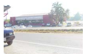
Aeropuerto de Lázaro Cárdenas
