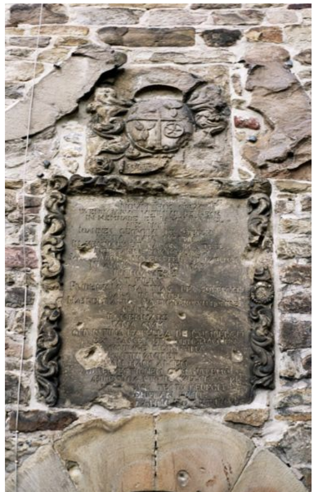
Eine wappenbekrönte Inschrift kündigt vom Ende der Wiederaufbauarbeiten
