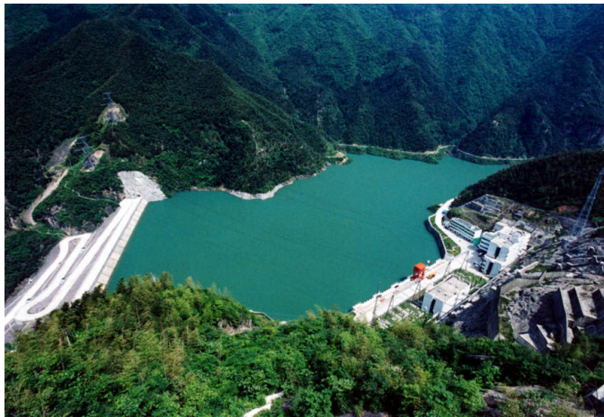
天荒坪电站下水库及中控楼
