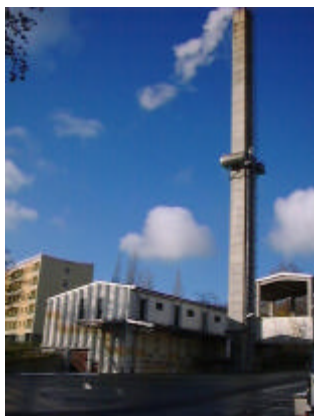
Nahwärmezentrale in Auerbach
