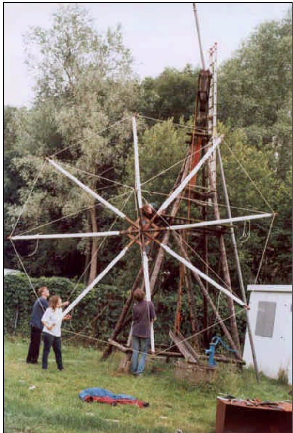
De WOT-terreingroep ontwikkelt nieuwe ideeën en onderhoudt de demonstratieobjecten op het WOT-terrein. Op deze foto wordt een nieuwe rotor voor de houten windmolen op het WOT-terrein omhooggetakeld.
