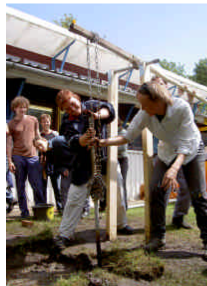
De cursisten proberen een put te slaan met de rotasludge methode
