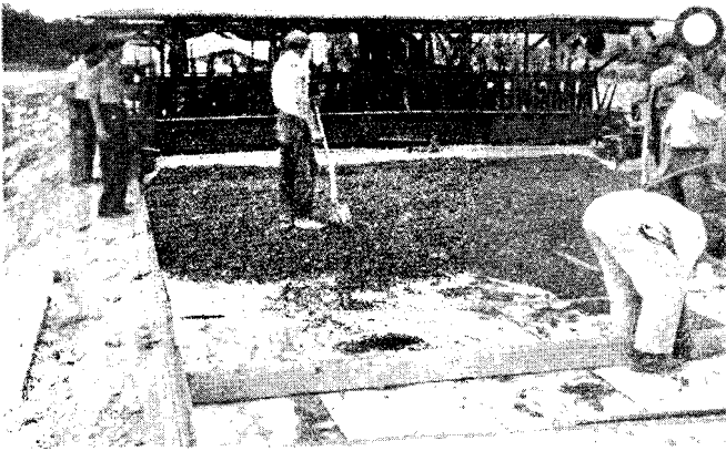
IZRADA KOLOVOZA OD CEMENTNOG BETONA
