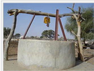
Le puits Samba Binta
