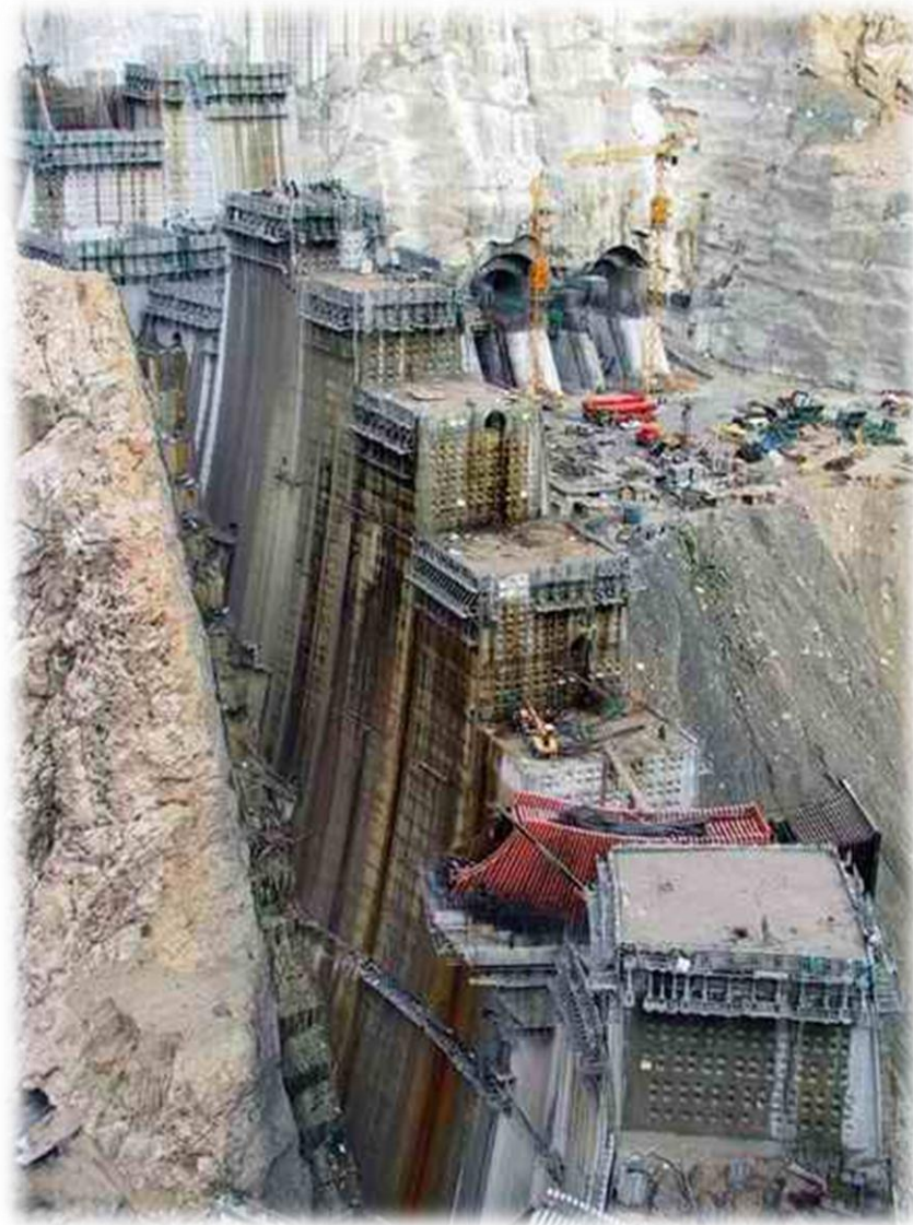
نمایی از سد کارون 3 در حال ساخت
