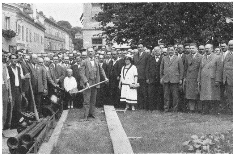
Feier des ersten Spatenstiches der Hochquellenwasserleitung am Hauptplatz in Schwechat.
