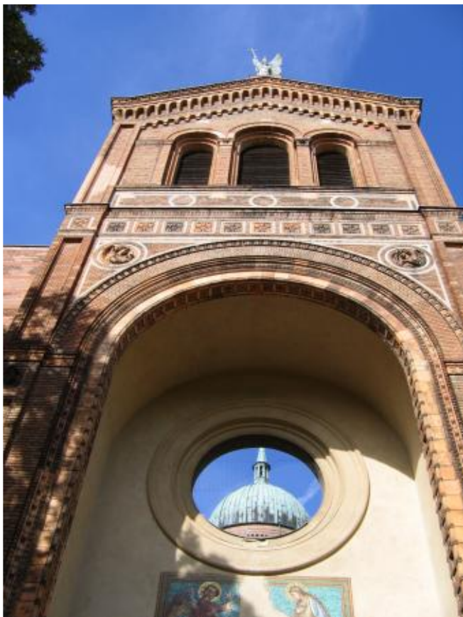
Die Hauptfassade der Sankt-Michaelskirche von vorne mit der Rundbogennische. Weil das Dach zerstört wurde, ist durch das Portalfenster die Kuppel zu sehen. Darüber das dreifenstrige Glockengeschoss. Ganz unten ist das Mosaik mit der Verkündigung zu sehen. Wegen des überstehenden Eingangs hat es die Zerstörungen teilweise überstanden. (Foto: Richardfabi)
