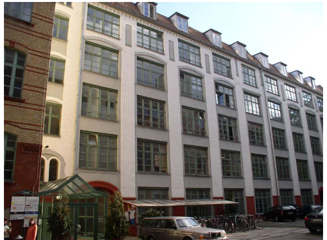
Abbildung 21 - Ehemalige Werkshalle des Propellerwerkes
