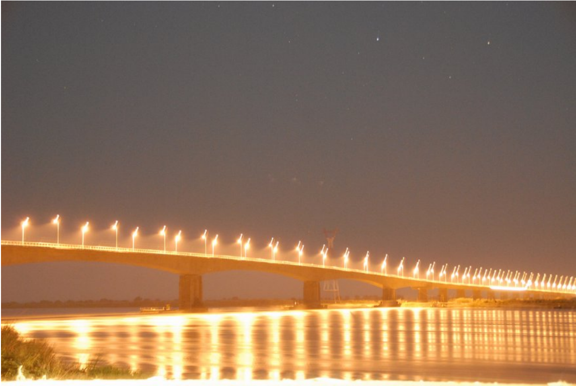
Vista parcial da Ponte Armando Emilio Guebuza sobre o Rio Zambeze
