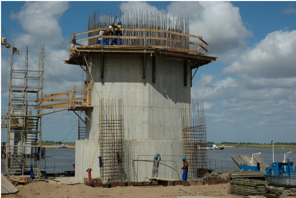
Construção de pilares
