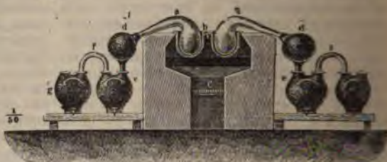
Фиг. 1. Газерная печь съ стеклянными ретортами и сосудами для сгущенія азотной кислоты (поперечный разрезъ).
