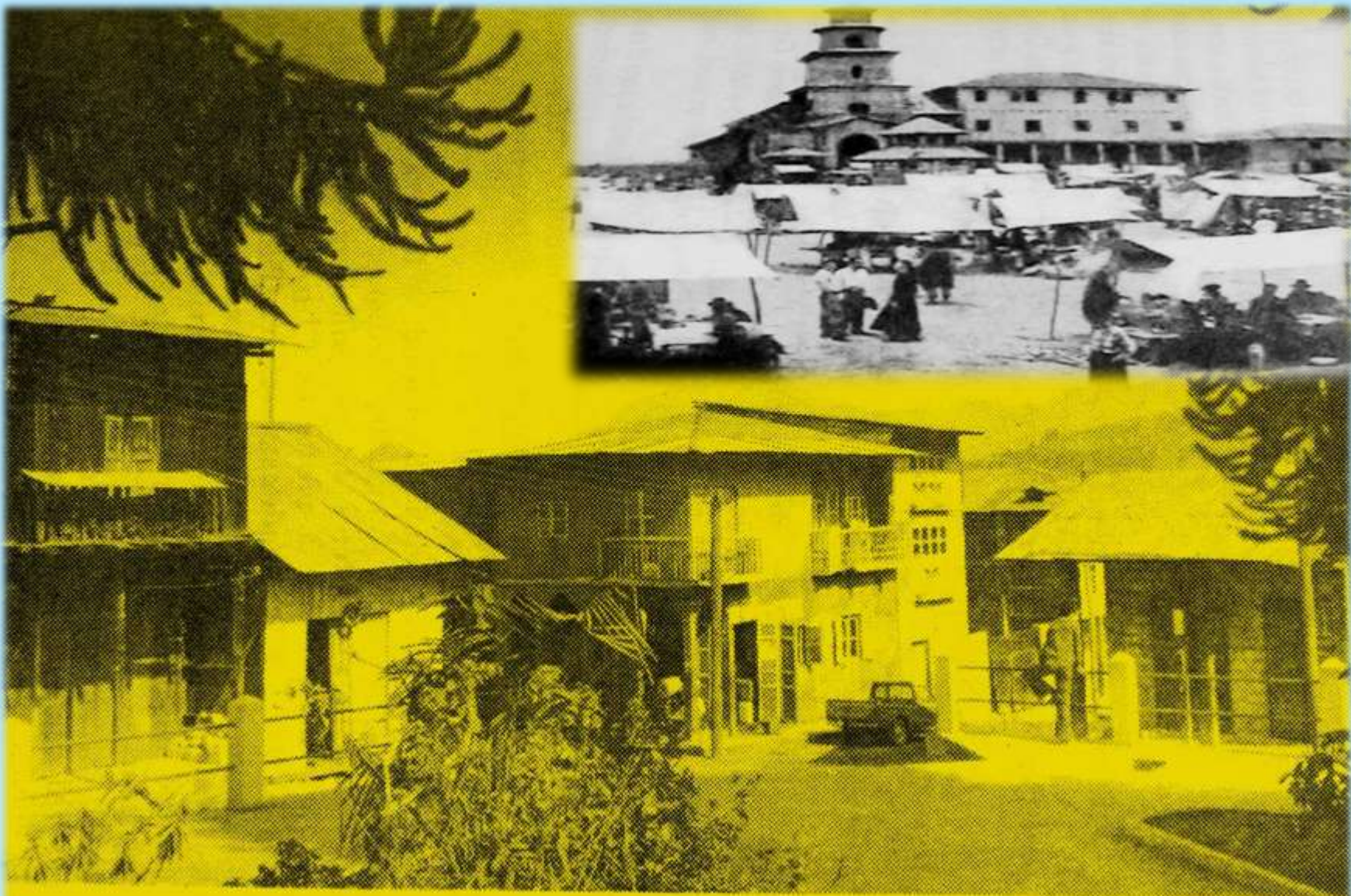
Estructuras de madera ahora reemplazadas por hormigón.
