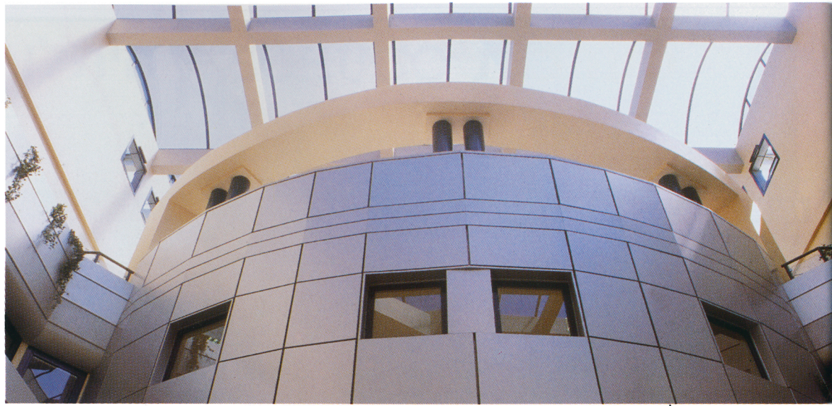
המשרדים הפונים לאטריום. offices in the Atrium.
