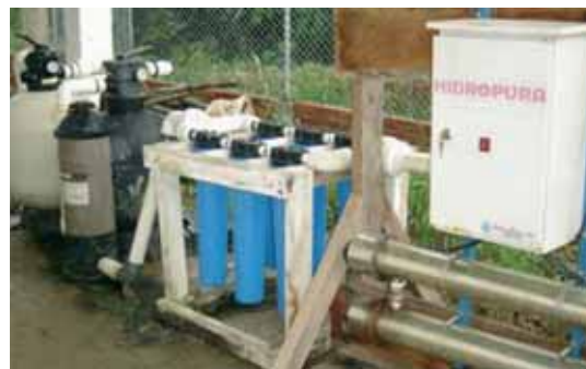
Figura 2. Filtros de arena, cartucho y luz ultravioleta necesarios para esterilización del agua marina.
