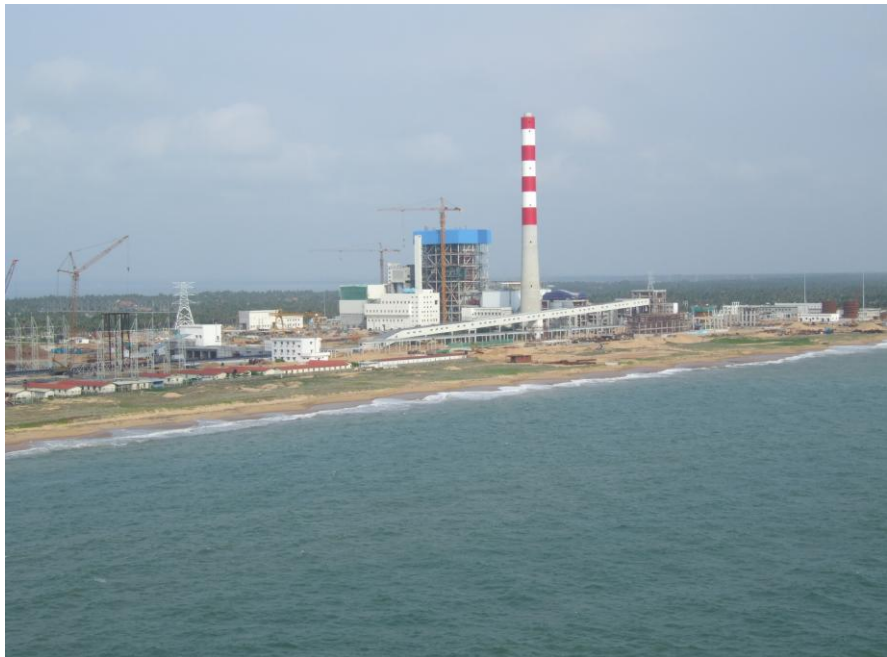
正在兴建中普特拉姆燃煤电站一期工程
