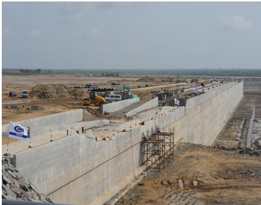
汉班托塔港口一期工程施工现场
