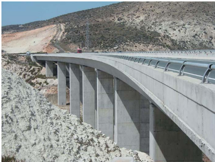
中国万宝工程公司承建的公路及大桥
