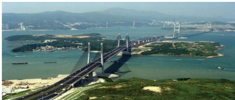
由青马大桥、汲水门大桥及马湾高架道路组成的香港青屿干线
