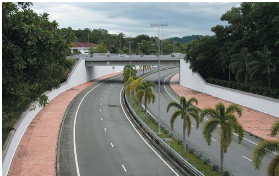
中国企业在文莱承包项目——立交桥
