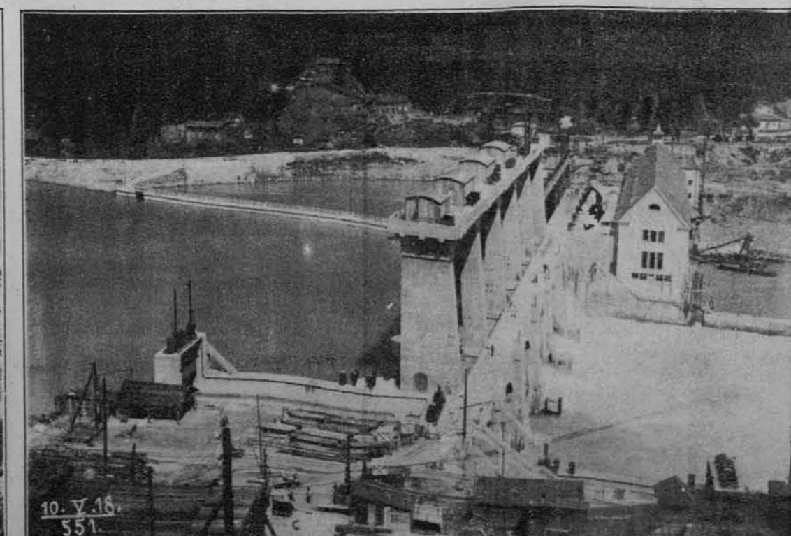
Zgradba se bliža svoji dovršitvi. (Slika z dne 10. V. 1918.)
