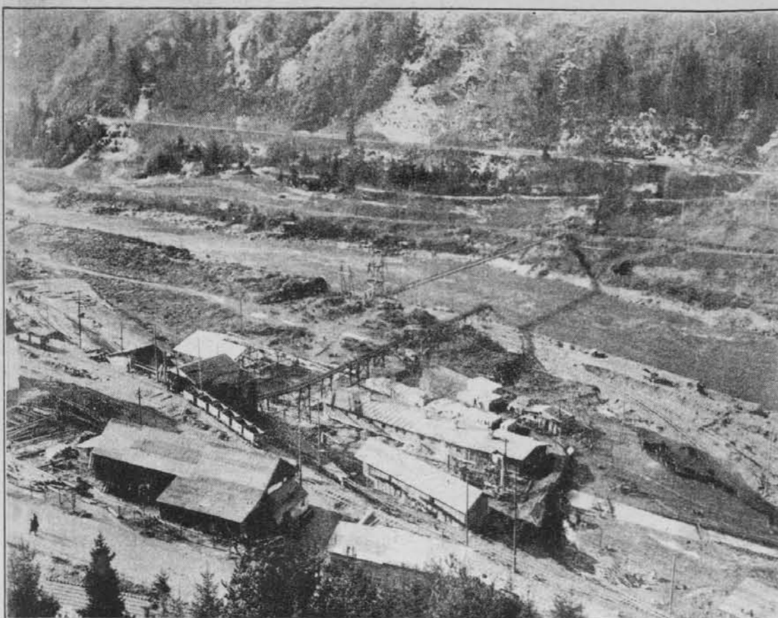
Postavljanje mehaničnih delavnic (instradacija zgradbe) in prva brv preko Drave (slika z dne 15. XII. 1913.)
