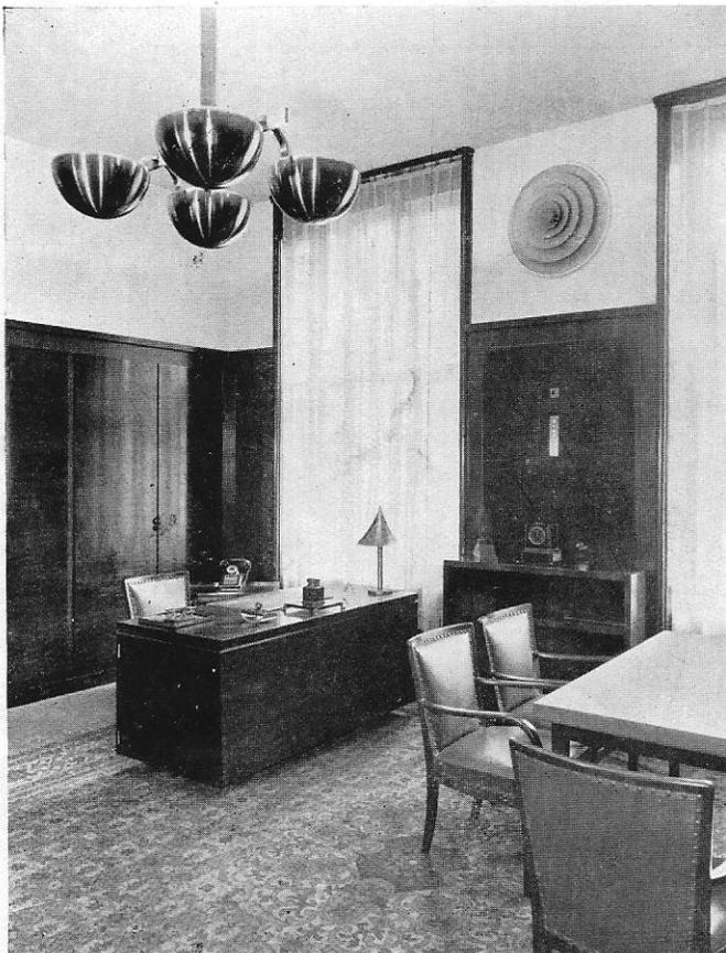
Büro eines Direktors. Wandverkleidung braune Eiche, Raumbelichtung indirekt, am Fensterpfeiler Anemostat für die Zerstäubung der Frischluft, ferner Notlicht und Personensucher
