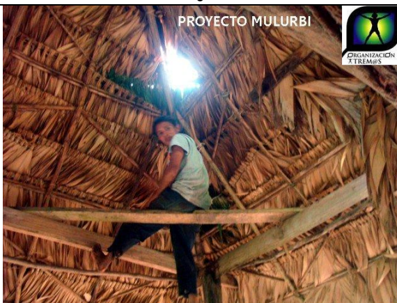
Compañero instalando en el techo las varas recién tejidas con palmas por nuestros ecovoluntarios
