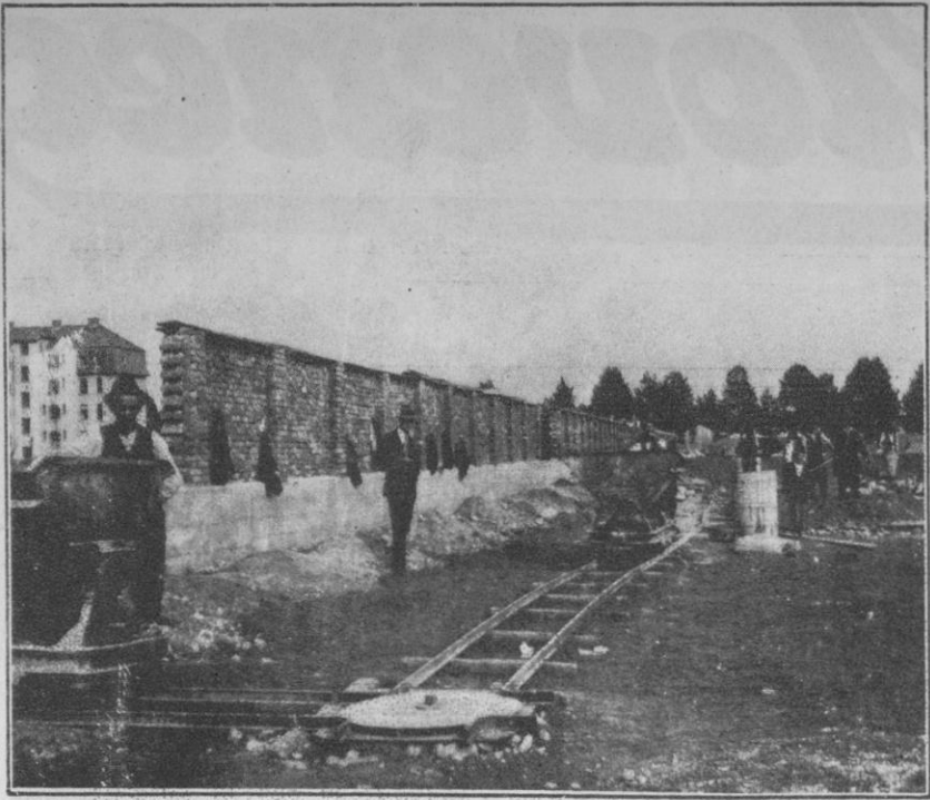
Gradba prvega slovenskega stadiona v Ljubljani, o katerem smo poročali že v zadnji številki: Postavljanje monumentalne ograje.
