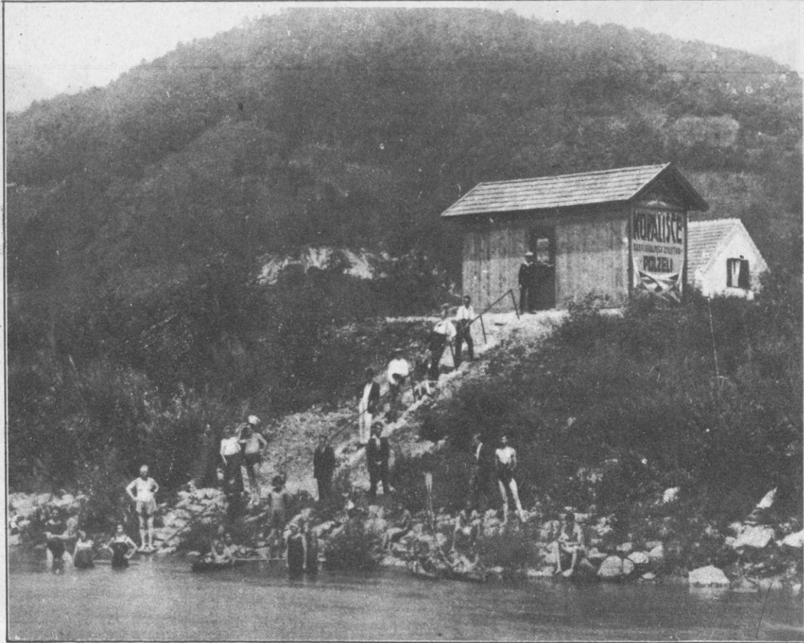
Novo kopališče v Polzeli ob Savinji, ki ga je zgradilo tamošnje olupševalno društvo.
