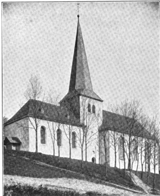
Südwestansicht der Kirche.
