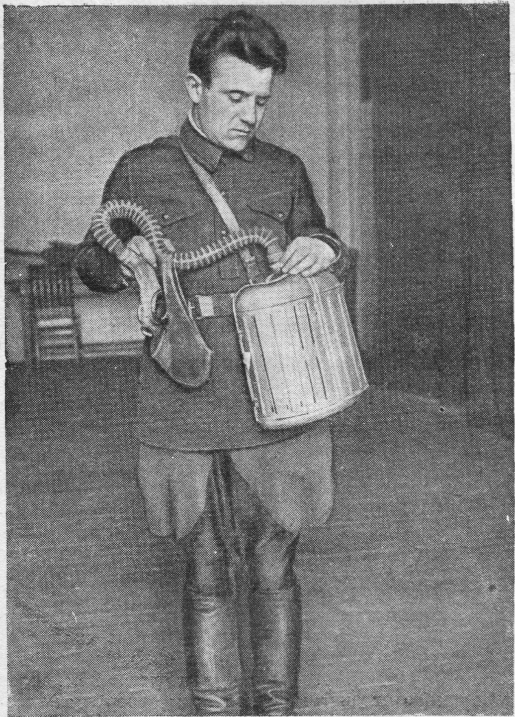
Рис. 6. Присоединение гофрированной трубки к соединительной коробке (см. стр. 18)
