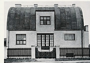
Lato su strada Da: Der Architekt XVI, 1910
