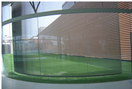
Fig13 bis. Parasol para impedir el efecto lupa de los cristales sin limitar la visibilidad.
