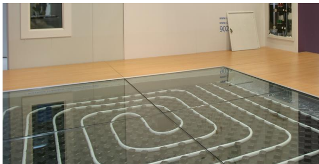
fig 26. Ejemplo a escala de suelo radiante.
