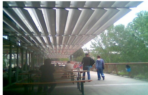
Fig 20. Detalle lamas solares en la UAB.
