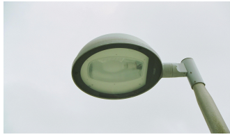
Fig 18. Farola no emisora de contaminación lumínica.
