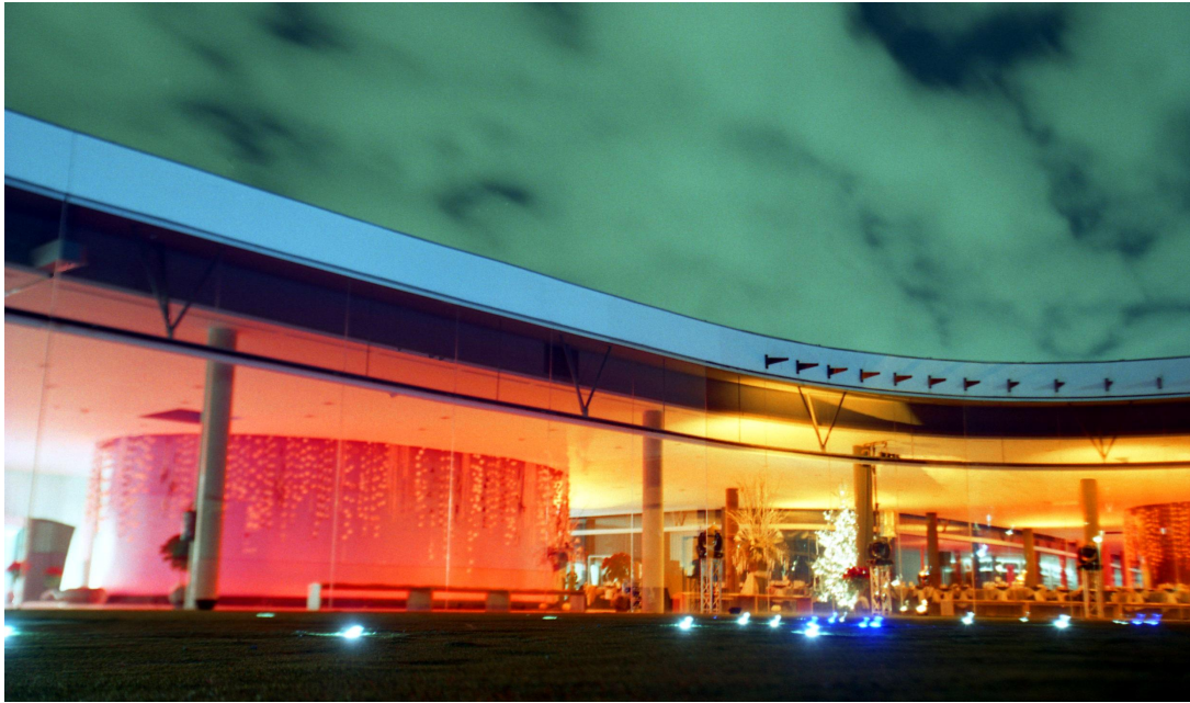
Iluminación mediante LED del recinto de Gran via de Fira de Barcelona mostrando las grandes posibilidades decorativas con una elevada eficiencia energética.
