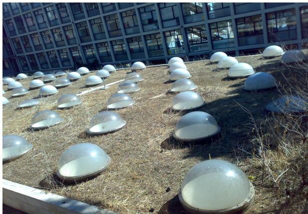
Característico captador solar mediante heliostatosen la cubierta de una universidad catalana.
