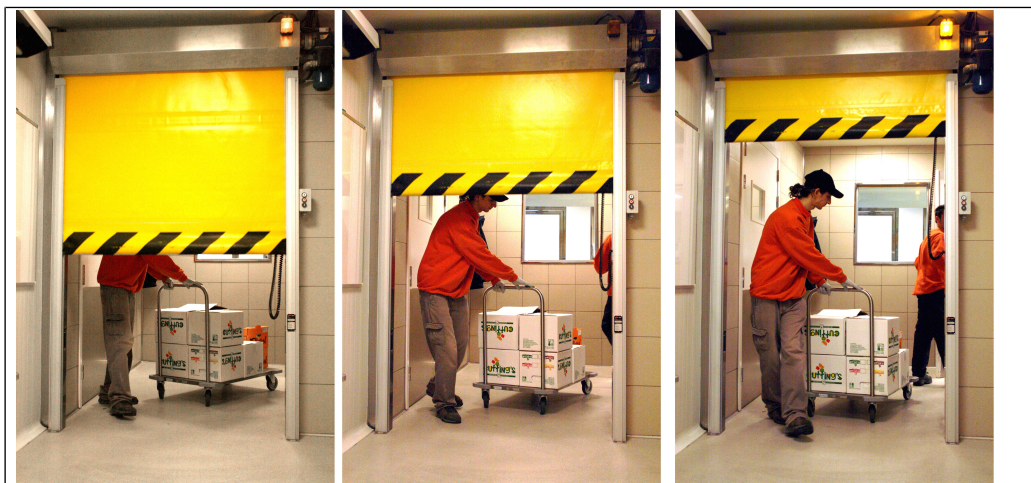
Fig 22 bis Puertas con sensor pueden reducir las pérdidas por el intercambio térmico entre interior y el exterior. (cocina de alto rendimiento de Gastrofira).
