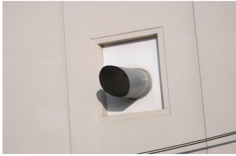
fig 8: Los extractores pueden ser un potente emisor de ruido .
