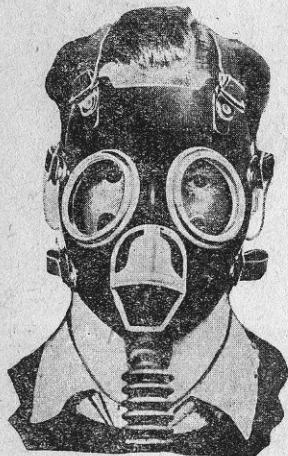
Рис. 31. Пемецкая маска с коническим клапаном, расположенным на передней части маски.
