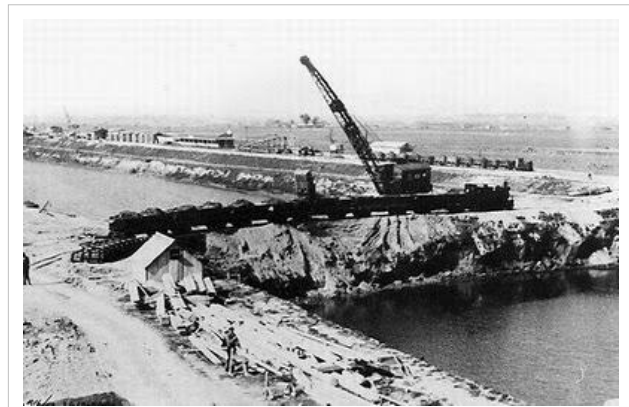
Obras de rectificación del Riachuelo en la década de 1930.
