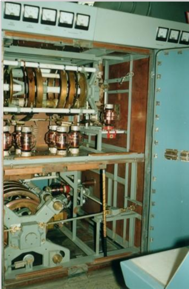
Operadores (arriba) unidad toroidal(Izq.)
