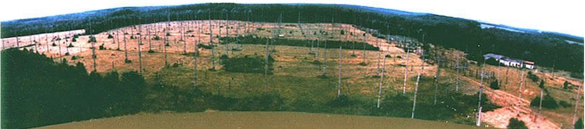
Vista de las antenas del proyecto Sura.
