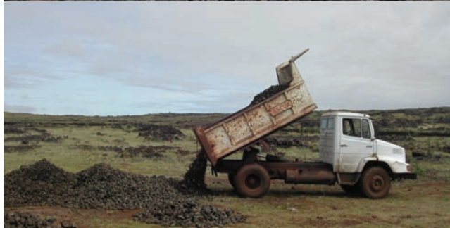
Acopio y selección manual del material para el nuevo relleno.
