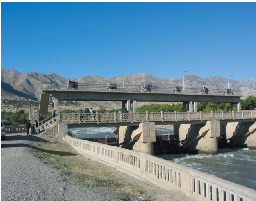
中国援助项目——帕尔旺水利修复工程
