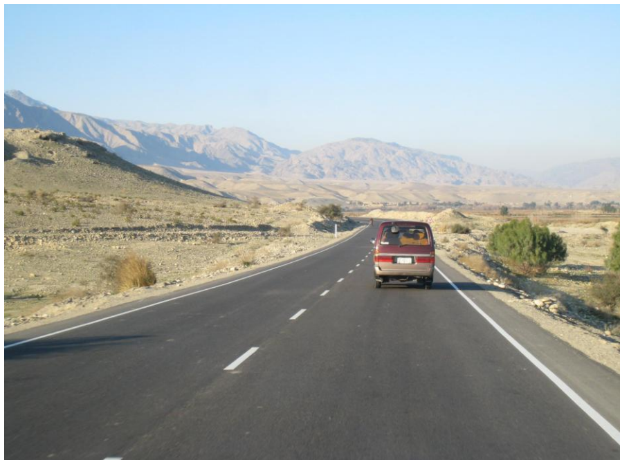
中国在阿承包工程：建成的贾拉拉巴德公路
