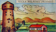
SERVICIO SANITARIO DE VILLA PALMIRA (MENDOZA)
