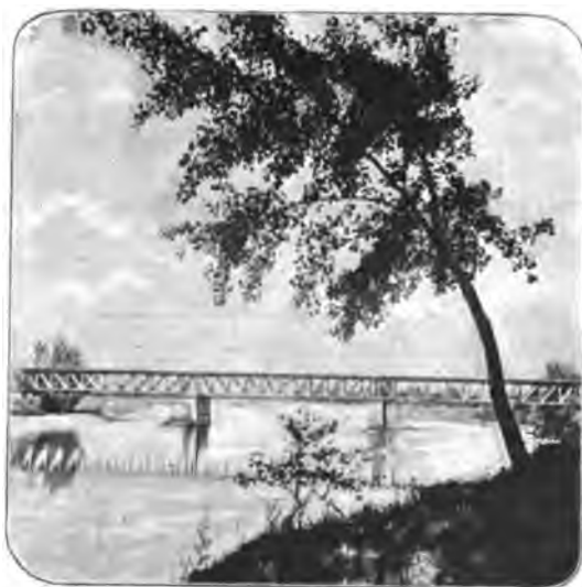
Мостъ черезъ Ворсклу на Харьковско-Николаевской ж. д. (По фот. Б. П. Алмазова).
