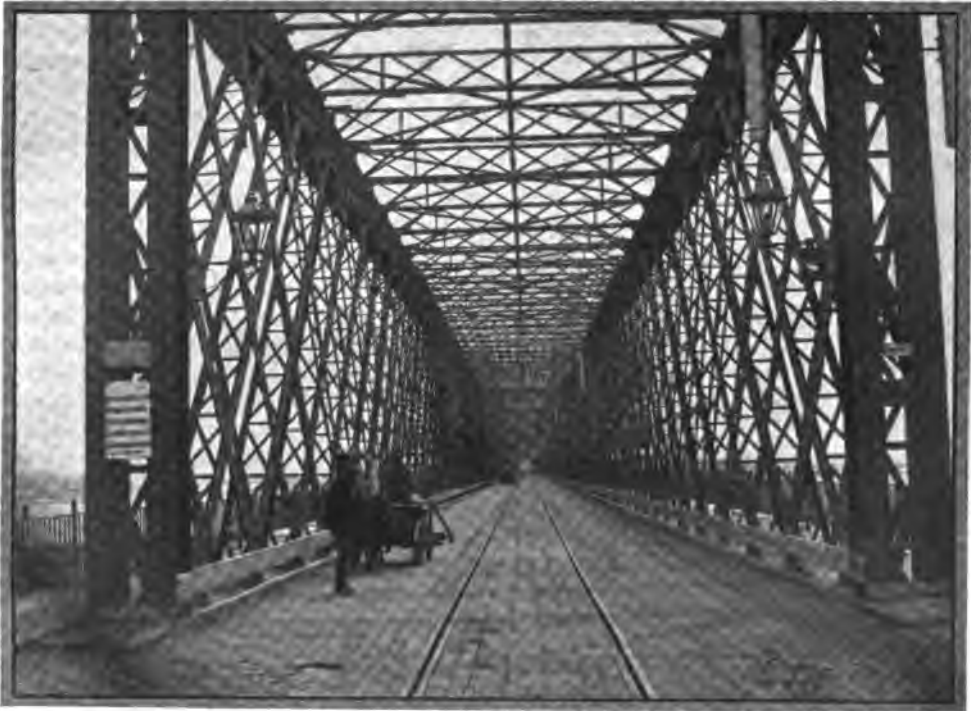
Кременчугскій мостъ на Днѣпрѣ.
