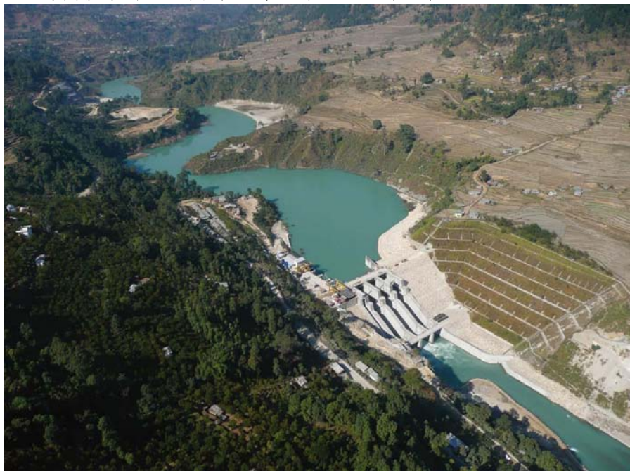
中国水利电力对外公司承建的70MW尼泊尔中马相迪水电站
