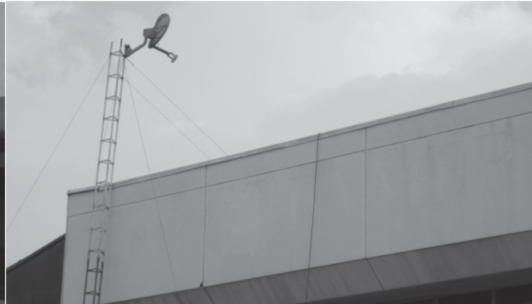
Fotografía central del Edificio de la Empresa Solucionara, ubicado de la Rotonda El Güegüense, 1 cuadra al Sur, 20 varas al Este, detrás del Edificio LaFise Bancentro. Ahí instalarían Siete E1, tres de Claro y cuatro de Movistar. Call Center propiedad de Teresa de Jesús Montealegre Callejas.
