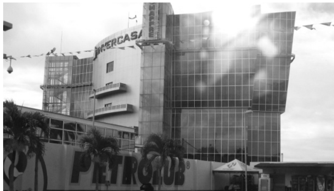
Fotografía central del Edificio Invercasa, ubicado contiguo a la Petronic de Villa Fontana. En el Cuarto Piso instalaron doce E1, tres de Claro y nueve de Movistar. Call Center ALMORI propiedad de Álvaro Rivas Montealegre.
