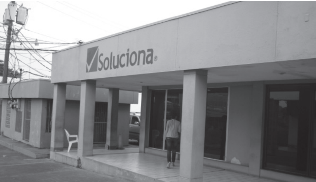
Fotografía central del Edificio de la Empresa Solucionara, ubicado de la Rotonda El Güegüense, 1 cuadra al Sur, 20 varas al Este, detrás del Edificio LaFise Bancentro. Ahí instalarían Siete E1, tres de Claro y cuatro de Movistar. Call Center propiedad de Teresa de Jesús Montealegre Callejas.
