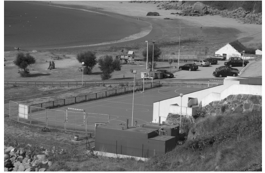
Figura 10 EDAR, en primer término, y campo de fútbol, sobre la antigua zona de dunas
