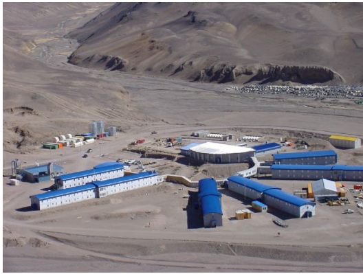
Actividad minera en la Cordillera de los Andes, proyecto Veladero en San Juan.
