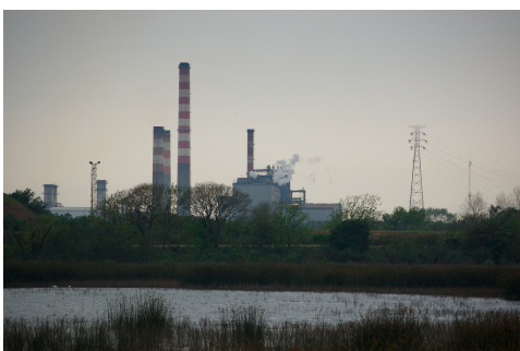
Central térmica Costanera, en la zona sur de Buenos Aires.
