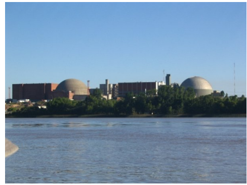
La Central nuclear Atucha fue la primera central nuclear construida en América Latina. [181] Argentina es la nación con mayor cantidad de instalaciones nucleares de la región.
