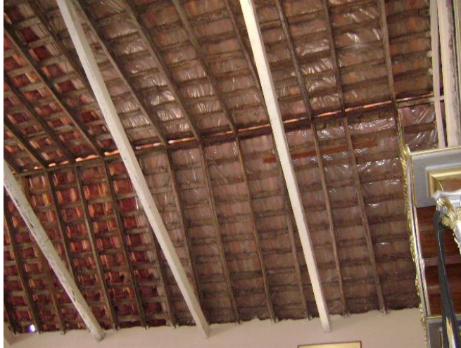
Foto 2. Interior de la cubierta
