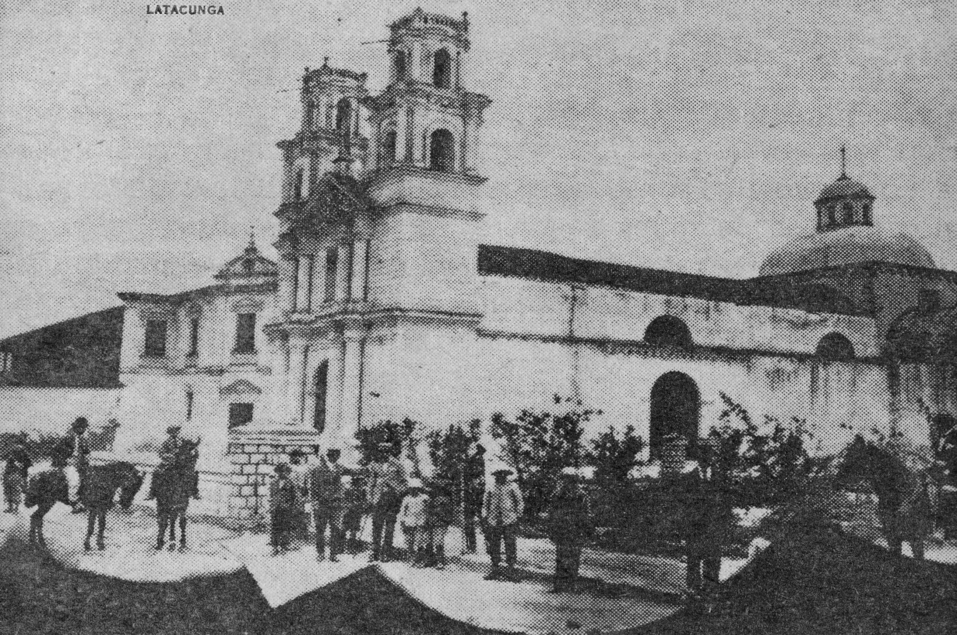
EL PARQUE Y LA IGLESIA DE SANTO DOMINGO EN 1.928.-FOTO IDEAL.-ARCHIVO PAREDEZ-BAUTISTA.
