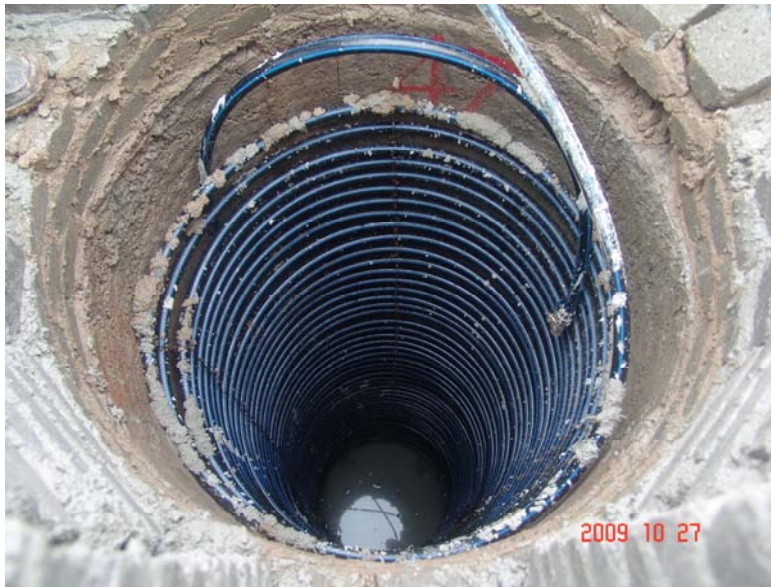
加压试验 pressure testing
