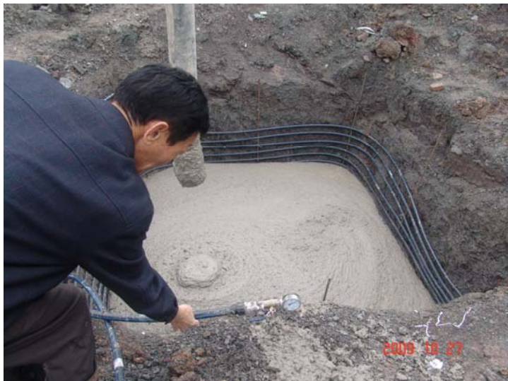
保压浇筑 Packing pouring system
