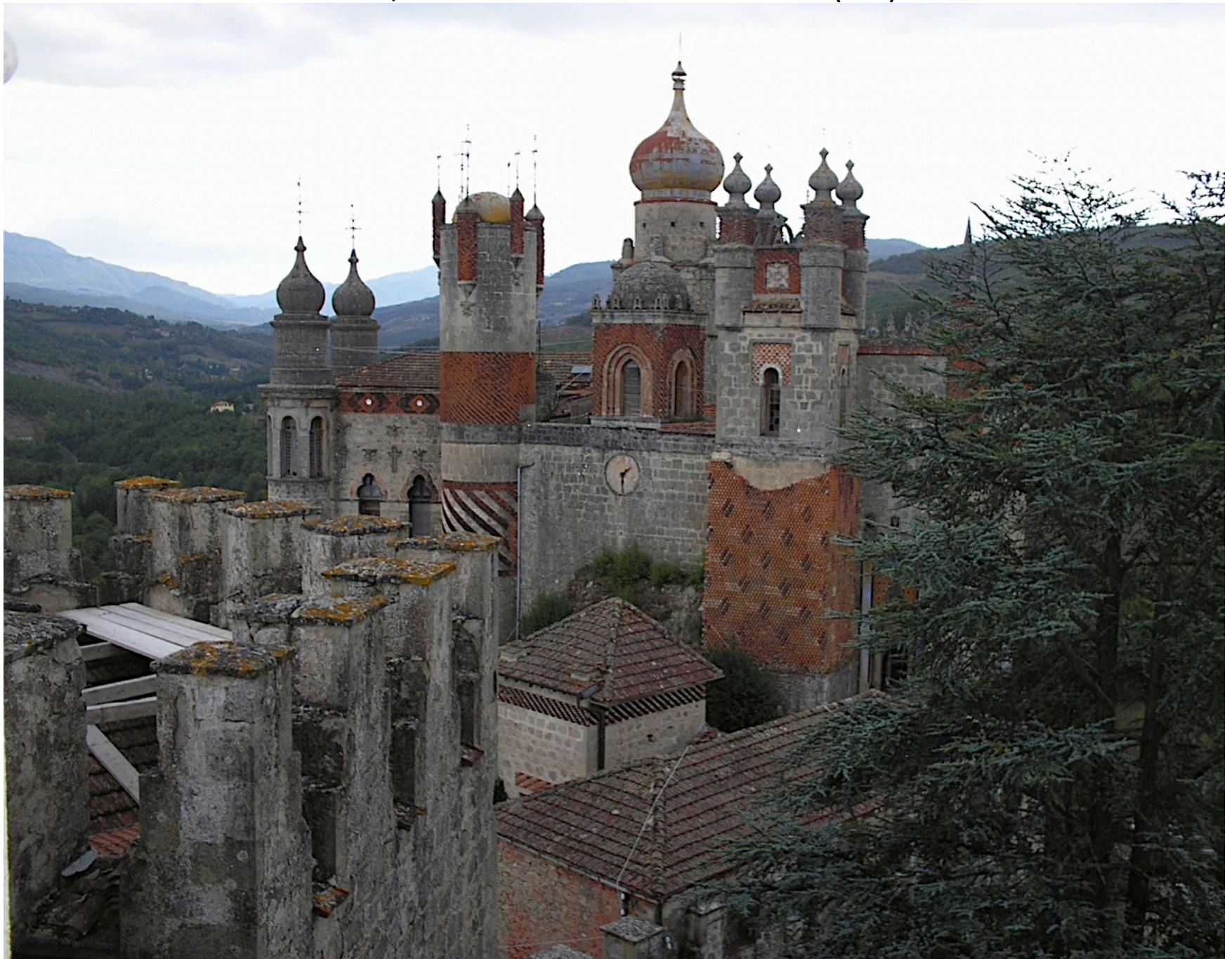
Rocchetta Mattei, Ponte di Grizzana Morandi (BO) 1850-59 c.a.
