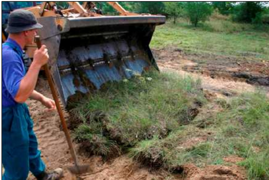
12. ábra: Védett növények gyeptéglás áttelepítése a győri Audi gyár telephelyének bővítésekor. (Fotó: TAKÁCS GÁBOR)
