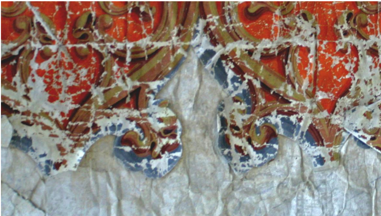
Abgerissene Nasen an der unteren Bordürenkante (Detailaufnahme Mitte)
