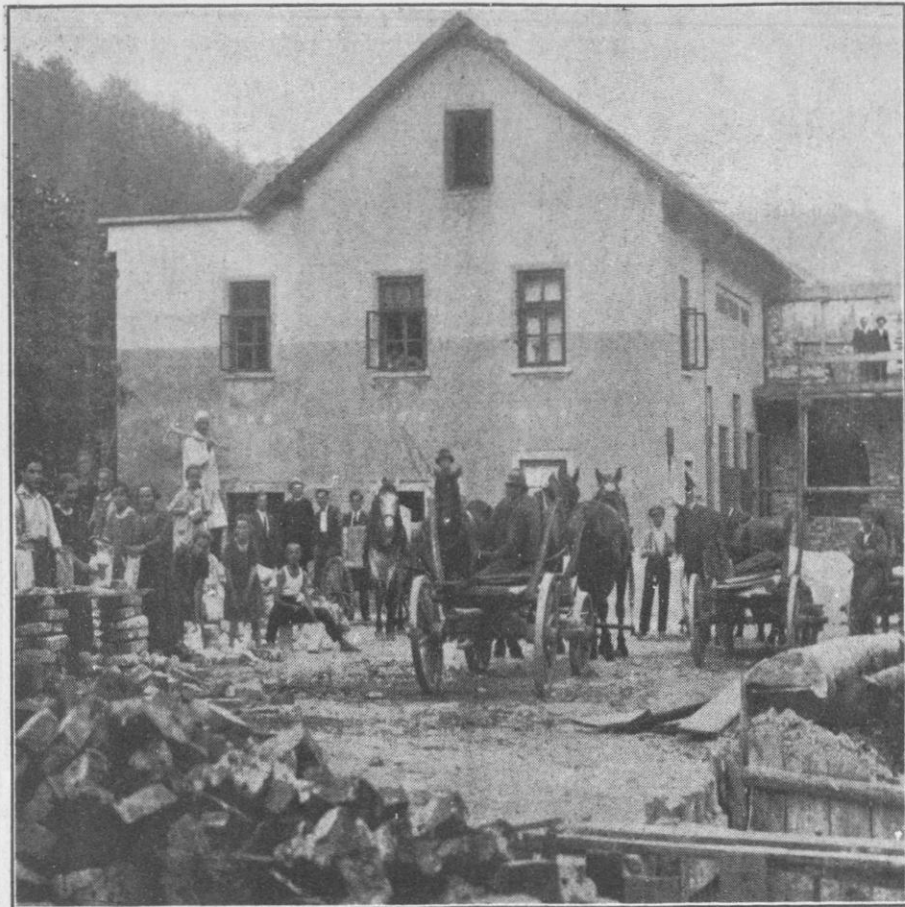
Kuluk pri gradnji novega društvenega doma v Trbovljah.
